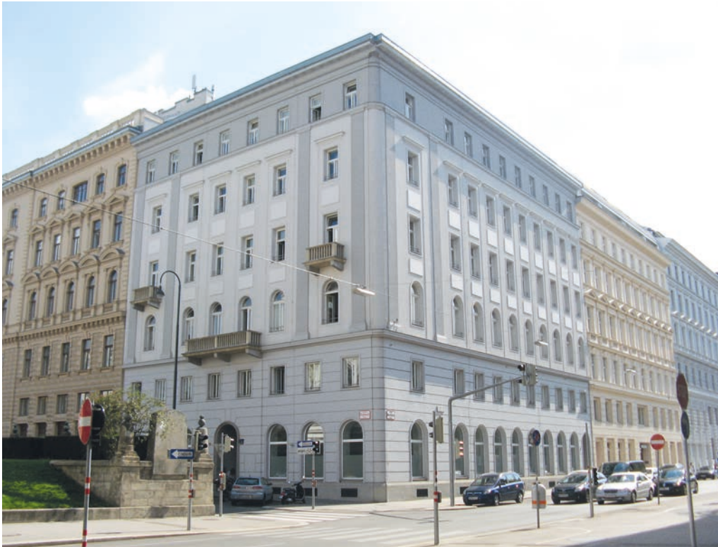
Abb. 11: Das ehemalige Haus der GPA am Deutschmeisterplatz
